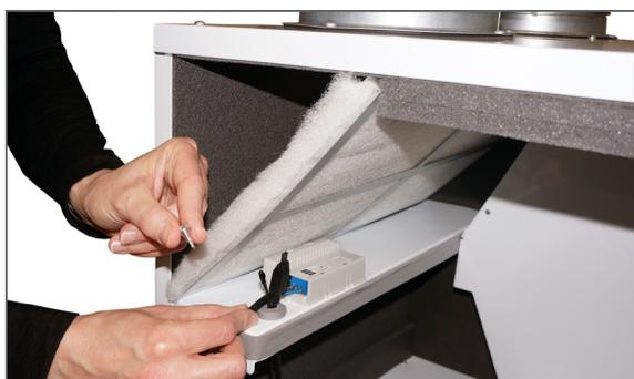
5. Le capteur CO2 est monté dans l'étagère en acier en dessous du filtre d'air d'extraction avec des vis auto-foreuses (un assemblage de capteur de CO2 est livré avec)...
