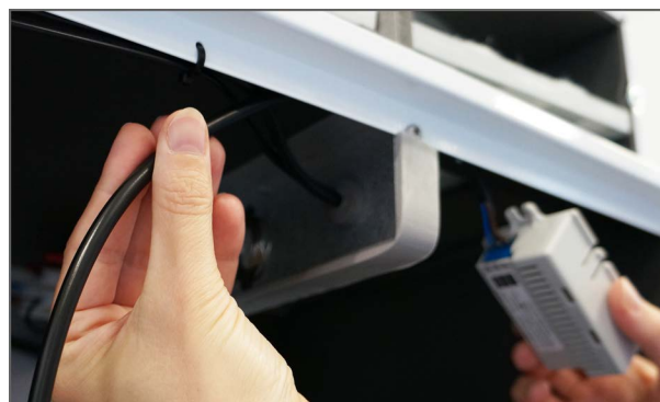
4. Passez le câble du capteur de CO 2 à travers ce trou.
