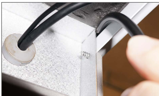
3. Percez un trou au travers de l'isolant et du cadre, au-dessus l'échangeur statique, pour accéder à l'espace supérieur.
