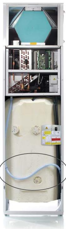
Le siphon est intégré au flexible, reliant le bac à condensation au drainage. Il est installé d'usine.
