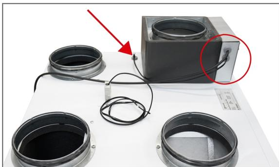
5. Le capteur de température de la surface de préchauffage est enfoncé à 8 cm dans le tulle. Ensuite, à l'intérieur de l'appareil, on peut le voir suspendu juste au-dessus du filtre à air extérieur.
