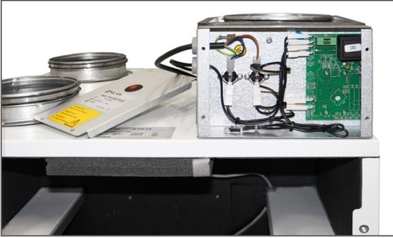
7. Le câble d'alimentation est pré-monté dans l'appareil et la surface de préchauffage est connectée à la phase (F), au zéro (N) et à la terre (J).
