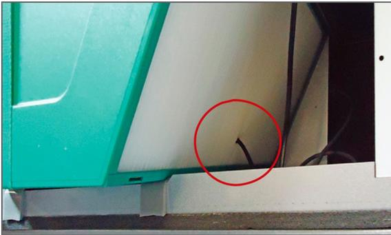
3. Le capteur T4 est retiré de l'échangeur à contre-courant.
