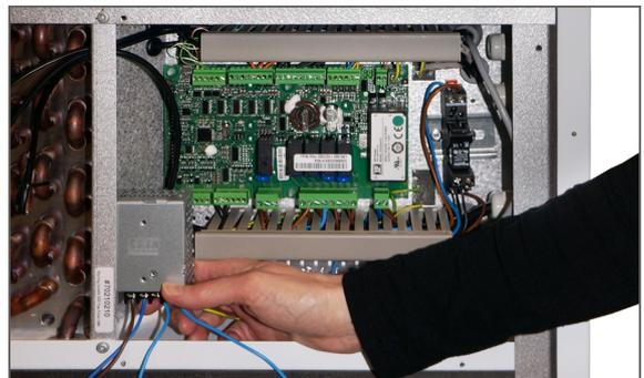
6. Faites passer le câble du capteur CO<sub>2</sub> par le conduit de câbles jusqu'au système de réglage automatique... Installez l'alimentation électrique dans le boîte pour automatisme dans l'appareil (Forez 2 trous pour les vis jointes)
