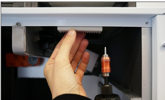
5. Montez la sonde de CO 2 sur le couvercle supérieur avec des vis autotaraudeuses.2..
