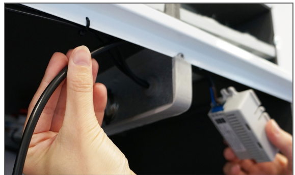
4. Faites passer le câble du capteur CO 2 par le conduit de câbles jusqu'au système de réglage automatique
