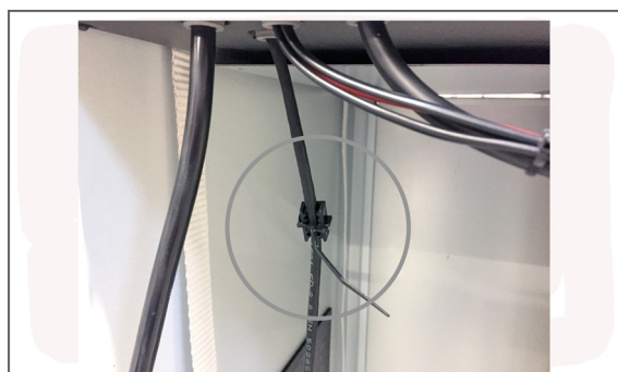
L'écarteur est fixé au câble LAN qui se trouve derrière la grande trappe.
