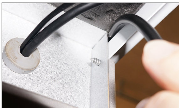
3. Percez un trou dans la mousse sur le faisceau (sous lequel se trouve l'échangeur) pour accéder à la cavité située dans le capot supérieur.
