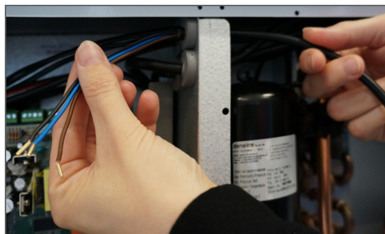
6. Faites passer le câble du capteur CO 2 le capteur par l'entrée du câble à l'automatique. Le fil est ensuite attaché avec des bandes de câbles.
