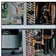
Un circuit de refroidissement réversible permet tantôt de chauffer l'air, tantôt de le rafraîchir.
