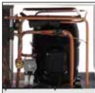
Le circuit de rafraîchissement est entraîné par un compresseur à piston stable.
