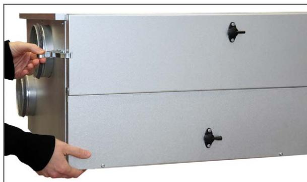
2. Les ferrures du coffret sont ouvertes des deux côtés et le couvercle est basculé vers le bas
