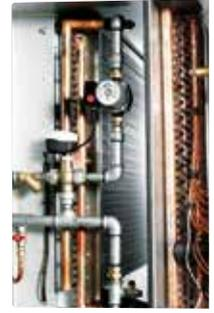
Circuit de mélange intégré pour batterie de chauffe à eau
